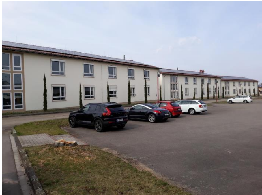
Foto 30: Blick auf die westliche Reihe von Gebäuden, Blick nach Norden.
