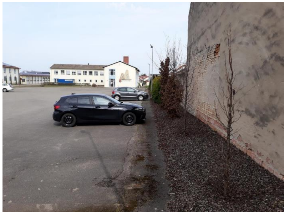
Foto 31: An der Südostseite grenzt das Vorhabens- gebiet an die entlang der Robert- Schumann- Straße stehenden Pri- vathäuser. Die Spalten in der Scheune bieten Habitat- potenzial für Fleder- mäuse.
