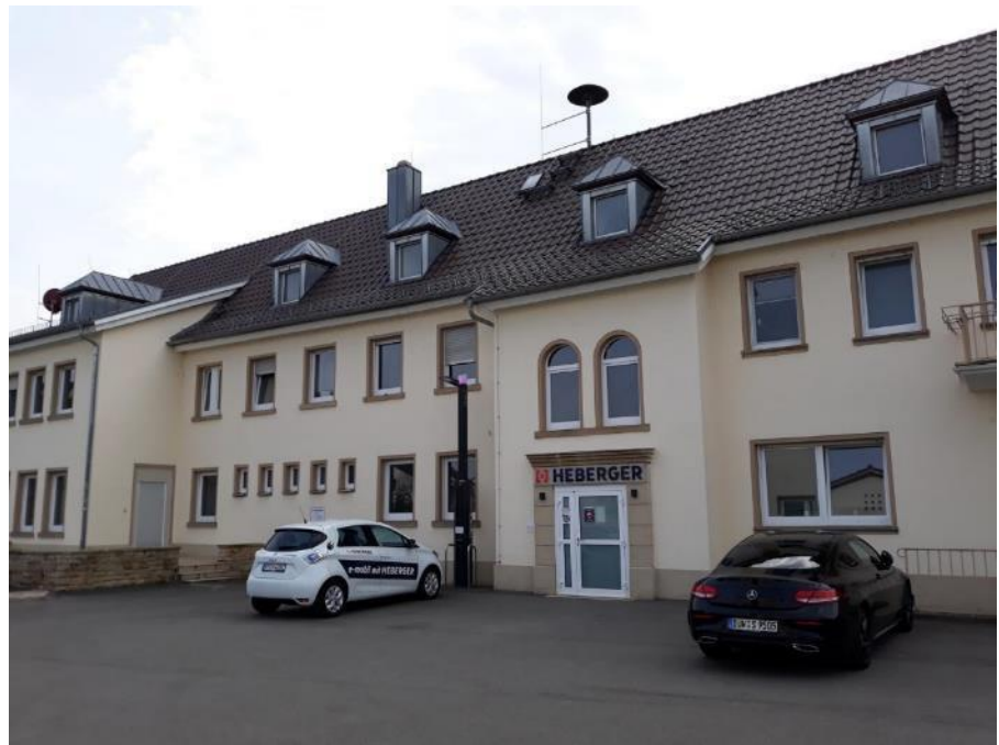
Foto 28: Blick nach Süden auf die Rückseite des Heberger-Firmengebäudes an der Bahnhofstraße (vgl. Foto 1)
