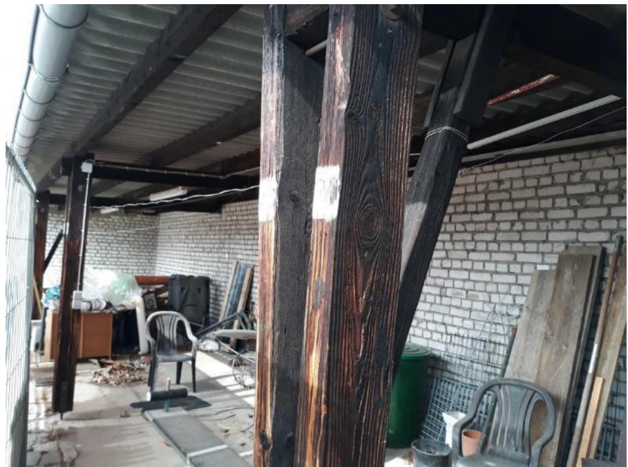
Foto 13: Entlang der nordöstli- chen Grenze befindet sich eine Unterstellflä- che, deren Balkenkon- struktion Brutplatzpo- tenzial für Vögel bietet...
