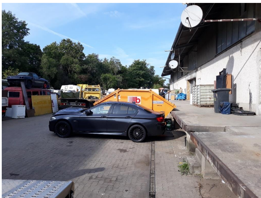
Foto 8: Blick nach Nordwesten entlang der abzureißenden Halle.
