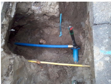
Bilder: Erneuerungen Hausanschluss und Hydrant
